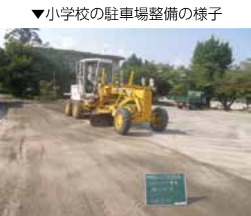
▼小学校の駐車場整備の様子
