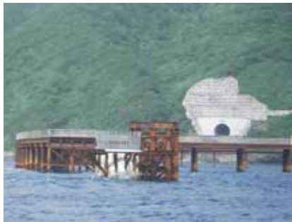
▲甕大橋の整備工事途中の様子
