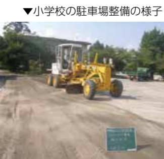
▼小学校の駐車場整備の様子
