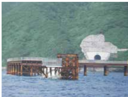
▲甕大橋の整備工事途中の様子
