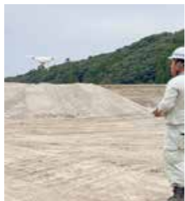
▲ICT(ドローン技術)を取り入れた作業の様子
