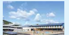
▲整備が進む川内文化ホール跡地
