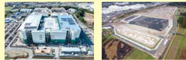
▲整備が進む京セラ株式会社鹿児島川内工場第23工場(左)と高城産業用地(右)
