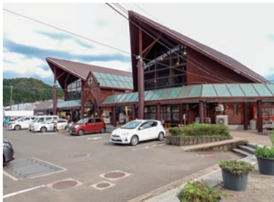
▲道の駅榎脇「遊湯館」
