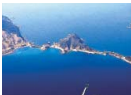
島を結ぶ甕大明神橋と鹿の子大橋
