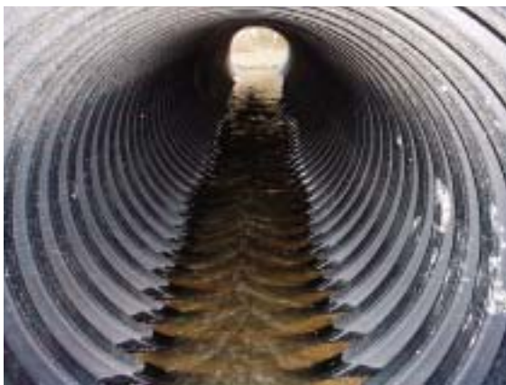
ボルゲート管を利用した落差工魚道
