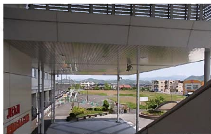
①駅東口から敷地全体を見る
