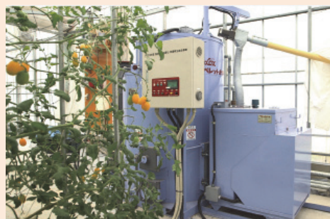
トマトの木質ペレット加温機 写真) 経済産業省 J-クレジット制度 HP
