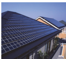
住宅用太陽光発電設備
