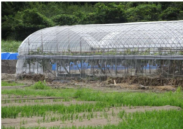
ハウス被災状況
