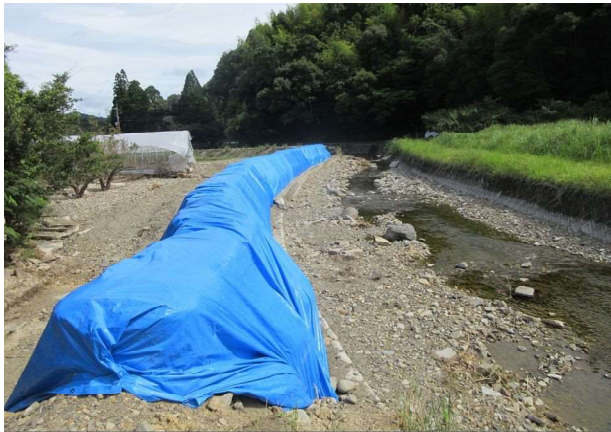
山田川被災状況（上流側から）
