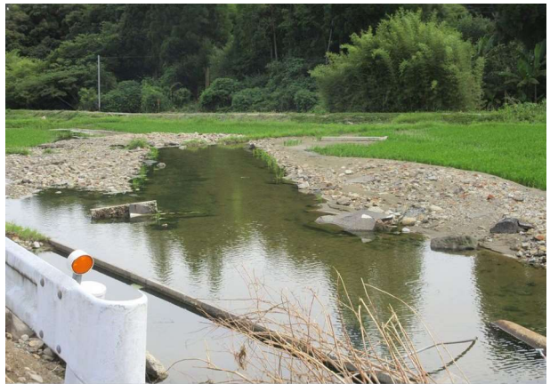
耕地被災状況
