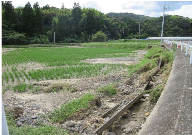
耕地被災状況
