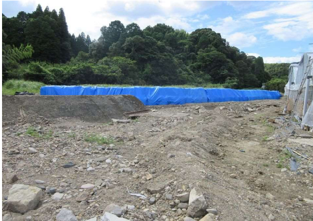
山田川被災状況（下流側から）
