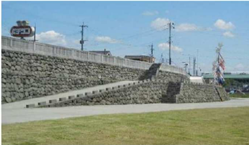
参考とするさつま町虎居地区の石積護岸 （一級河川 川内川）
