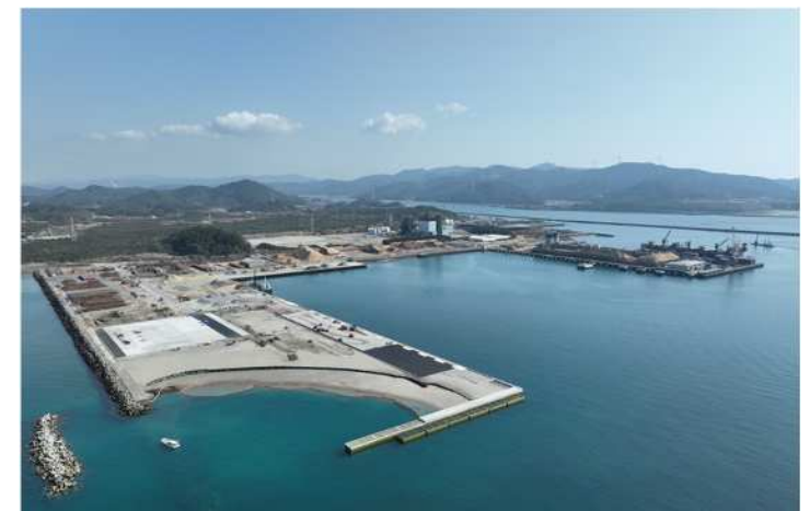
令和8年3月 川内港航空写真
