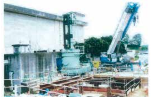
水道設備(配水池)耐震化工事
