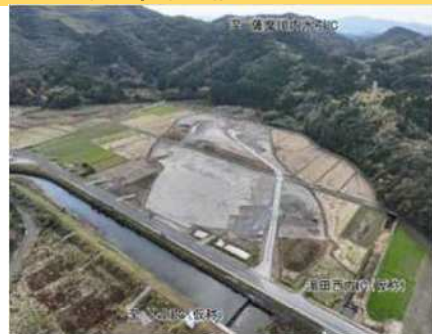
湯田西方IC 地盤改良工事
