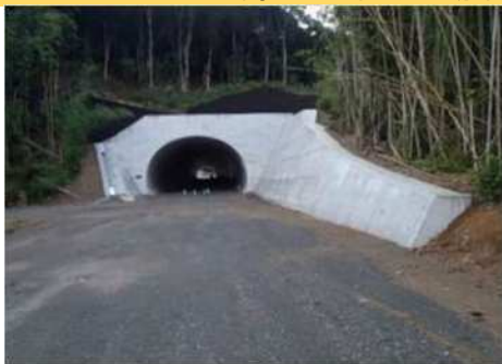
草道トンネル完成（網津トンネルから改称）
