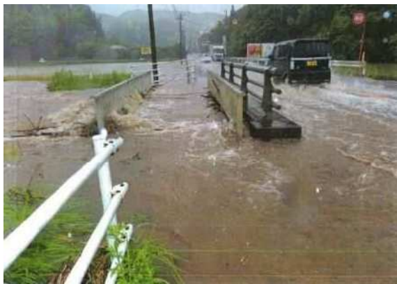
小倉川（国道3号冠水状況）
