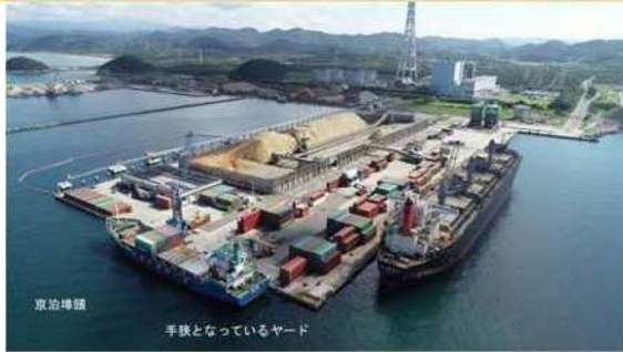
手狭となっているヤード（京泊ふ頭）
