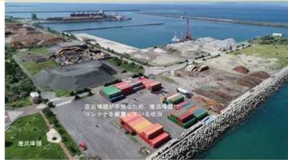
コンテナヤード不足による唐浜ふ頭への横持ち輸送や仮置き
