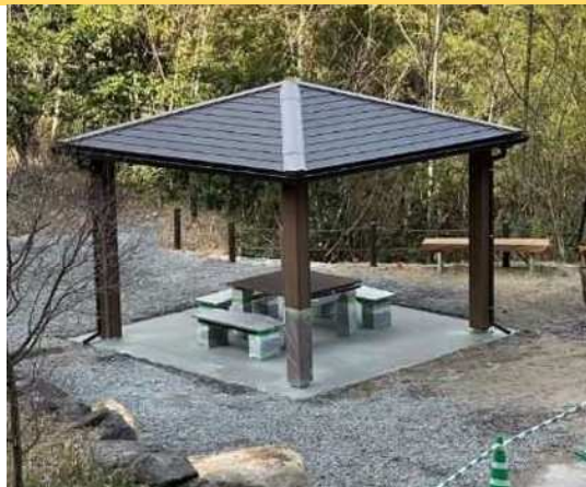
地域振興推進事業 藤本滝公園整備事業（令和5年度東屋整備）
