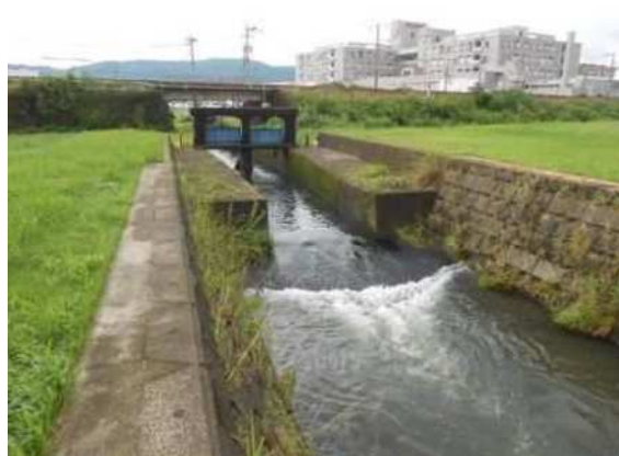
銀杏木川（堰狭隘部）
