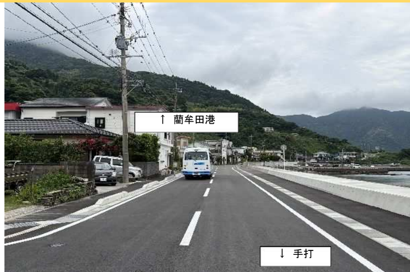
整備後の状況
