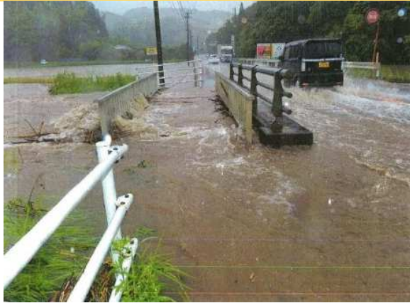
小倉川（国道3号冠水状況）
