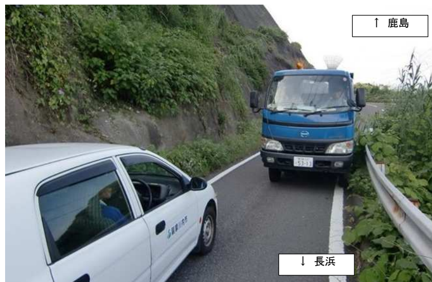
未改良区間 狭隘で離合困難な状況
