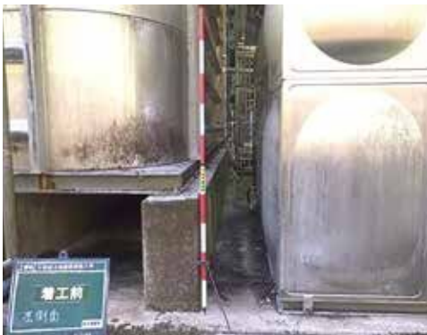
配水池耐震補強工事（着工前）
