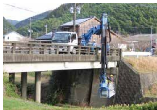
寺川内橋点検
