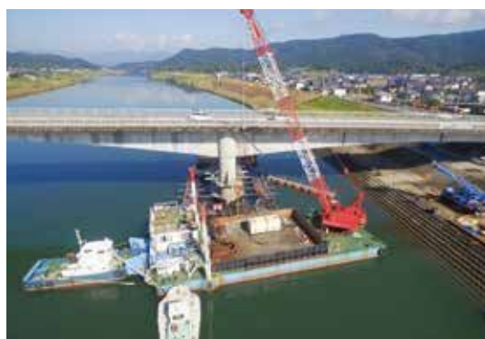
天大橋補修工事
