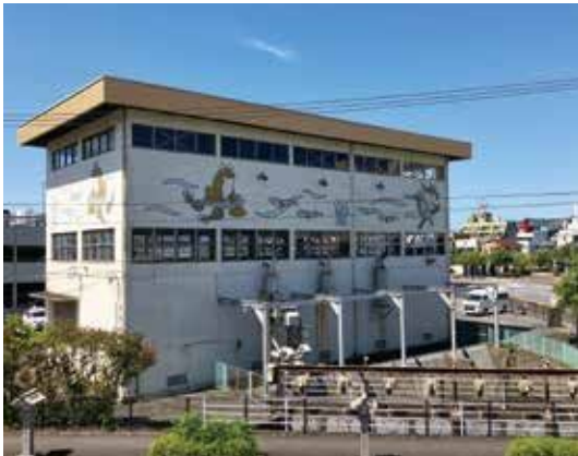
向田ポンプ場（雨水）
