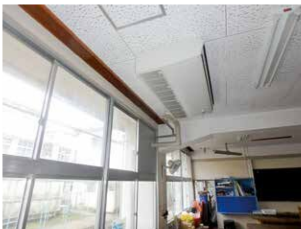
教室への空調設置
