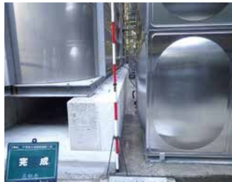
配水池耐震補強工事（完成）
