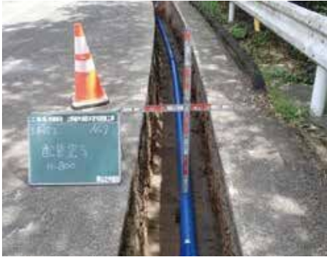
高密度ポリエチレン管布設（耐震管）
