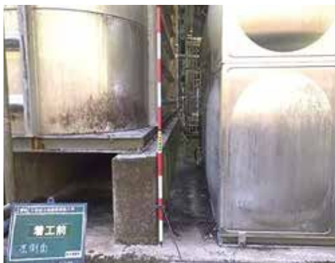
配水池耐震補強工事（着工前）
