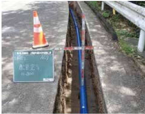
高密度ポリエチレン管布設（耐震管）
