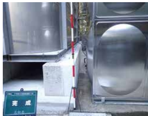
配水池耐震補強工事（完成）
