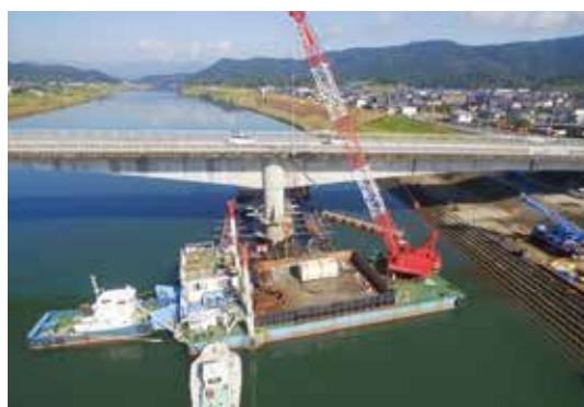
天大橋補修工事
