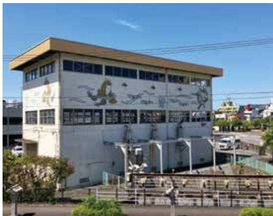
向田ポンプ場（雨水）
