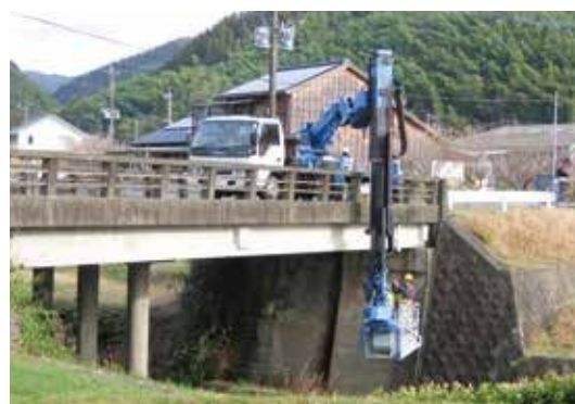
寺川内橋点検
