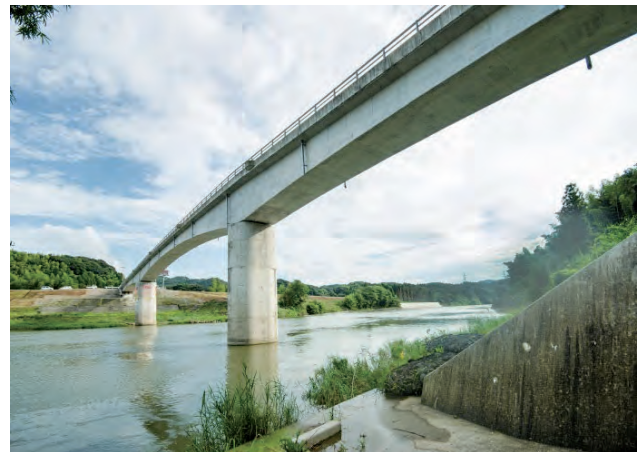
久住橋復旧後（H22年3月完成）
