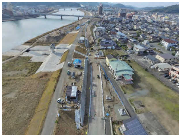
川内市街部改修（大小路地区）
