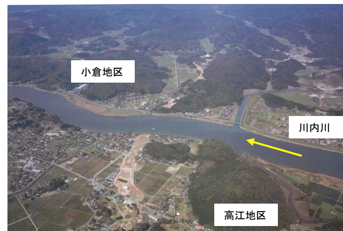
建設中の川内隈之城道路（H21.3撮影）
