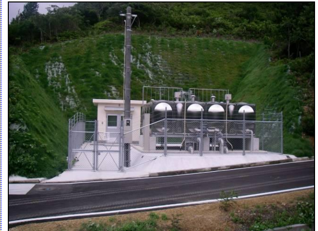
桑之浦第一配水池
