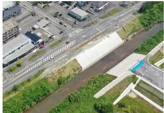
主要地方道川内加治木線接続部 （平佐川架橋）
