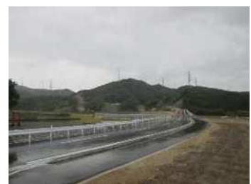
原子力発電所迂回道
