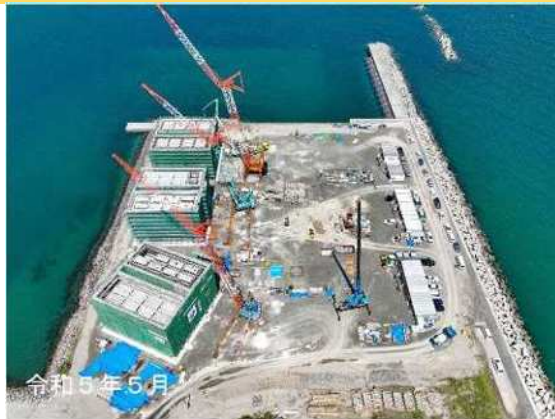
着々と進むケーソン製作工事
