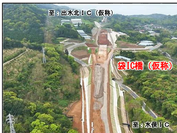
芦北出水道路（袋IC(仮称)付近）
