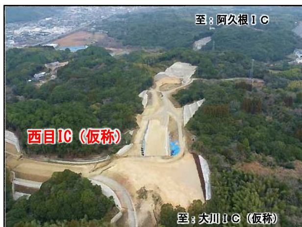
阿久根川内道路（西目IC(仮称)付近）
