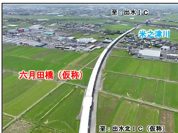
芦北出水道路（出水北IC(仮称)～出水IC間）
