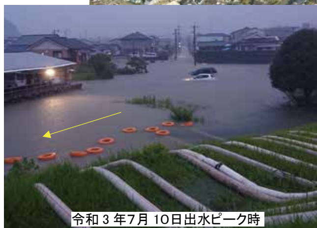
内水被害が懸念される虎居樋門
