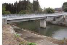
コンクリート橋：西之原橋（2012年 薩摩川内市樋脇町）
