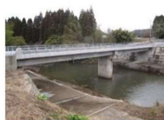
コンクリート橋：西之原橋(2012 年 薩摩川内市樋脇町)
