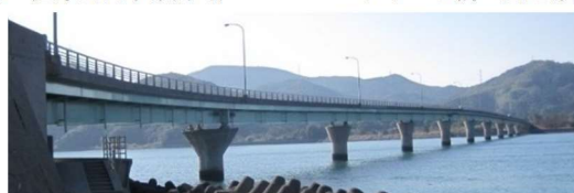
鋼橋：川内河口大橋(1981 年 薩摩川内市港町)
