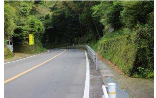
番号19 県道吉川川内線（県道341号）
