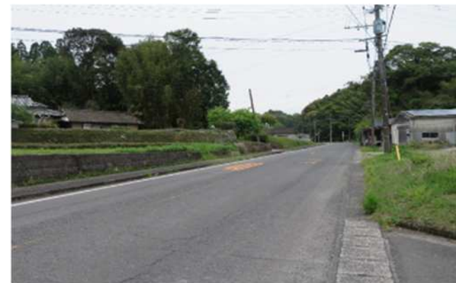
番号21 県道薩摩祁答院線（県道 369号）
