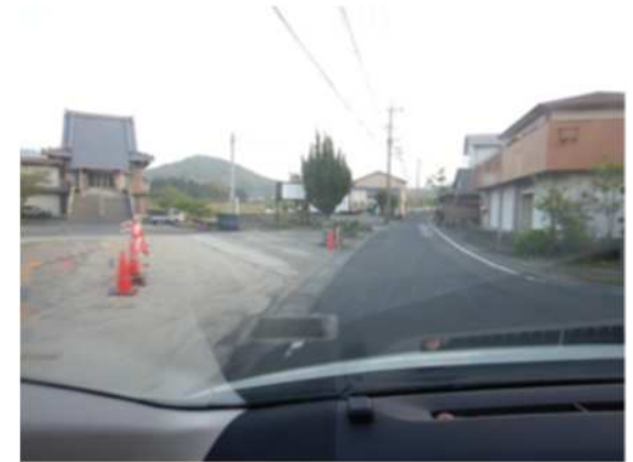
番号36 県道荒川川内線（県道313号）
