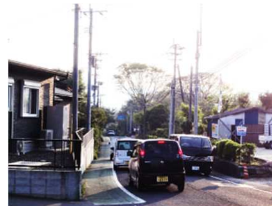
番号25 県道山田隈之城線（県道336号）
