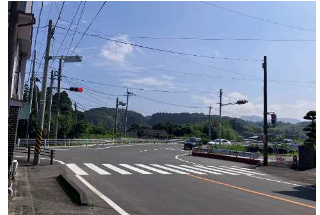
番号19 県道39号線（串木野樋脇線）
