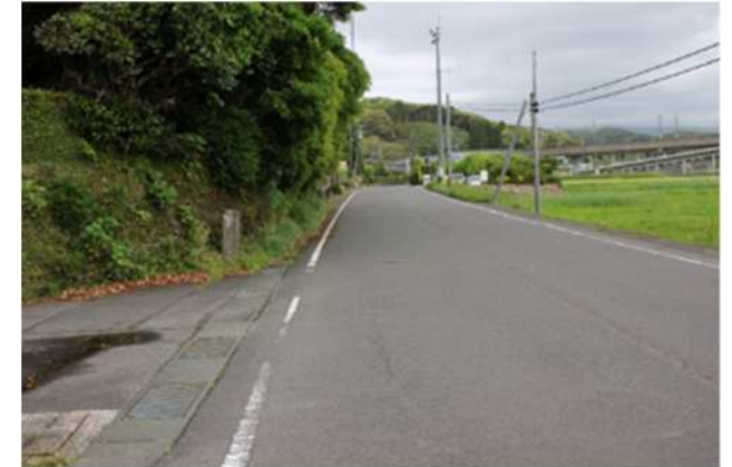
番号12 県道吉川川内線（県道341号）
