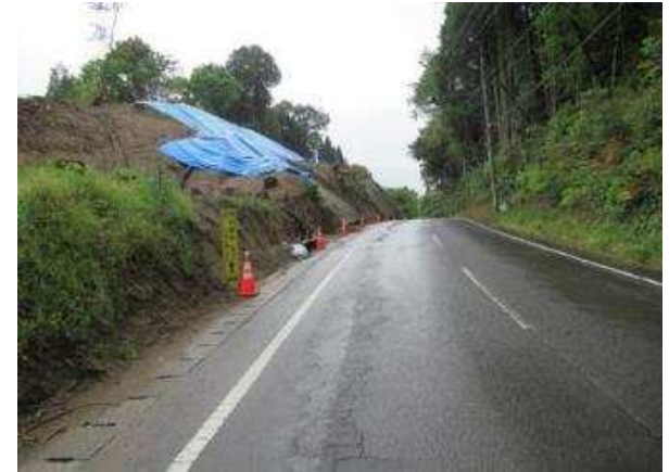
番号41 県道薩摩祁答院線（県道396号）
