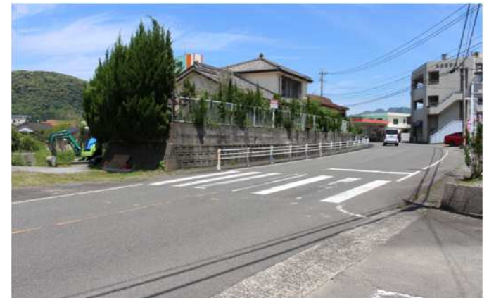
番号17 県道39号線（串木野樋脇線）
