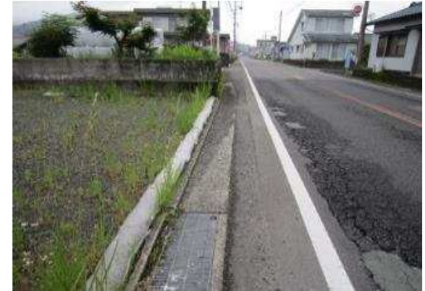
番号13 県道荒川川内線（県道313号）
