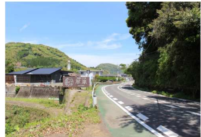
番号15 県道39号線（串木野樋脇線）
