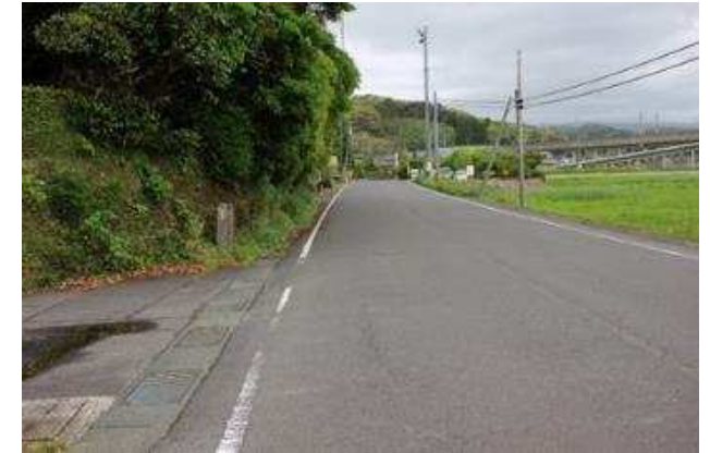
番号18 県道吉川川内線（県道341号）
