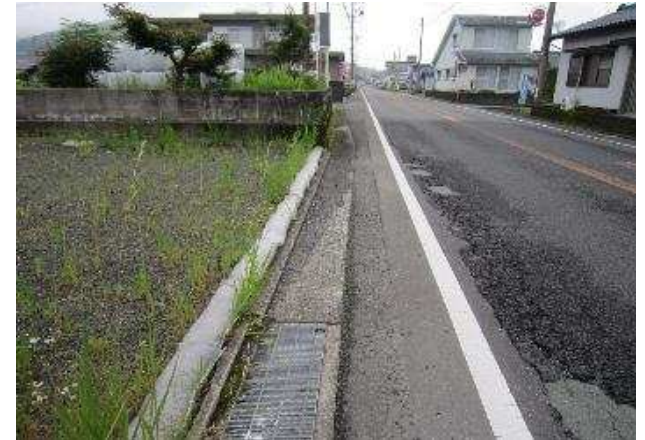
番号7 県道荒川川内線
