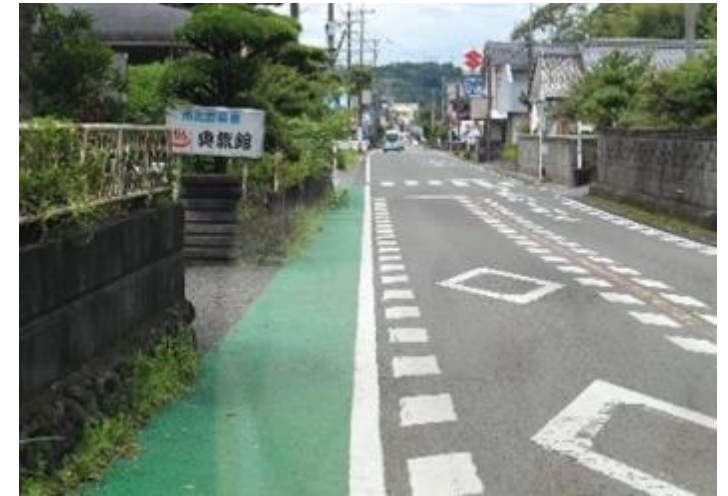
番号23 県道串木野樋脇線 (県道39号)
