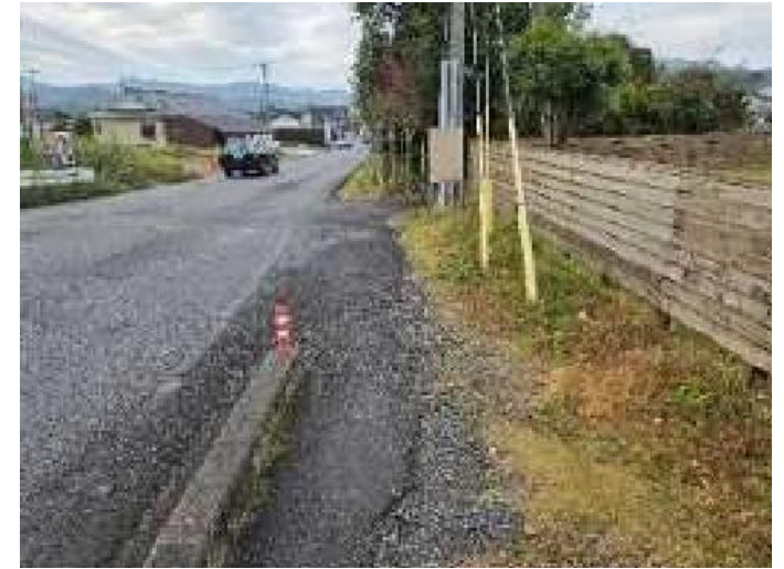
番号17 県道荒川川内線
