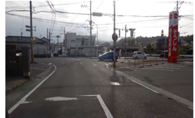
番号37 県道山田隈之城線（県道336号）
