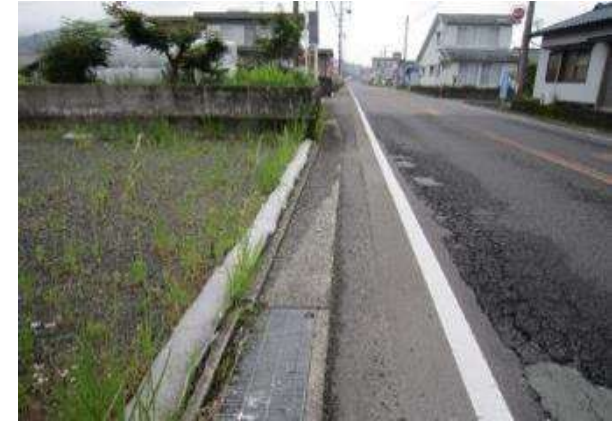
番号13 県道荒川川内線 (県道313号)
