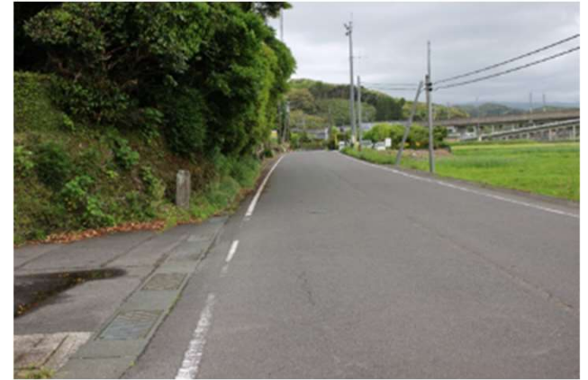
番号12 県道吉川川内線（県道341号）
