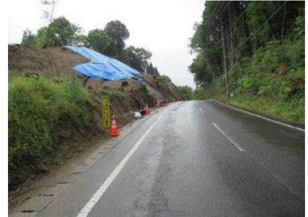
番号41 県道薩摩祁答院線（県道396号）
