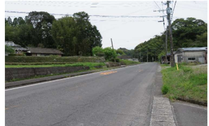
番号21 県道薩摩祁答院線（県道 369号）
