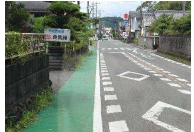
番号23 県道串木野樋脇線 (県道39号)
