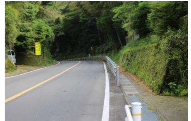
番号19 県道吉川川内線（県道341号）
