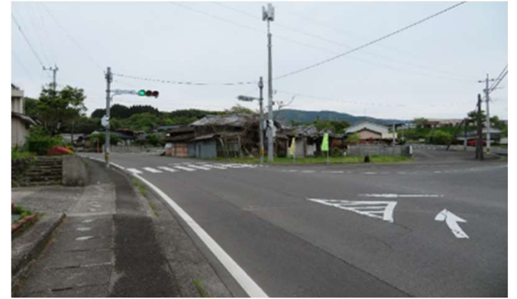
番号23 県道薩摩祁答院線 ( 県道396号)
