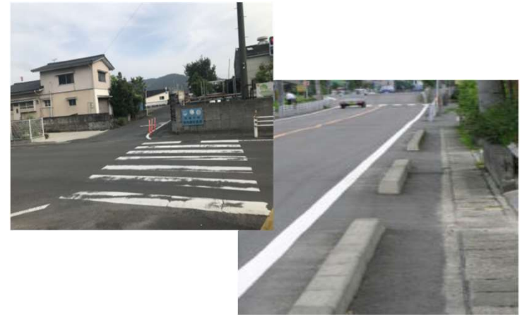
番号1 県道京泊大小路線 (県道44号)
