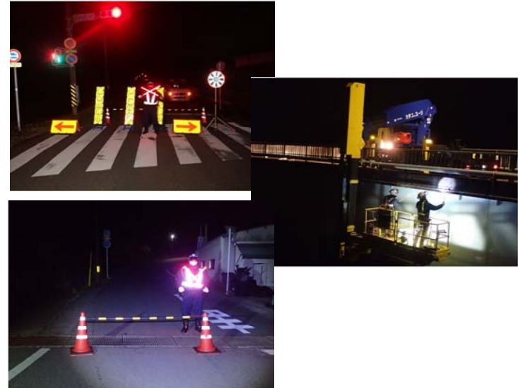
【白浜橋点検状況写真 2022年1月】
