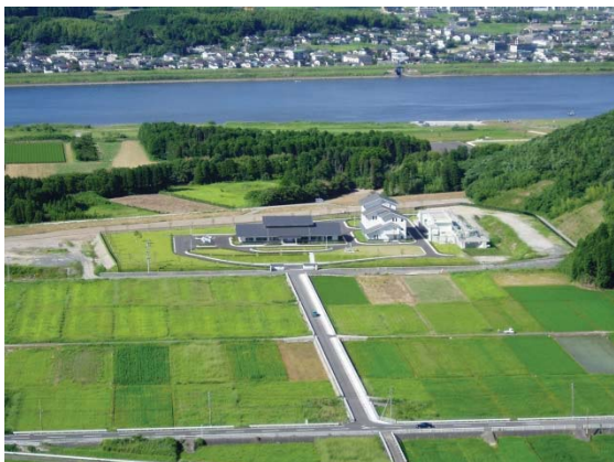
宮里浄化センター（宮里町）
