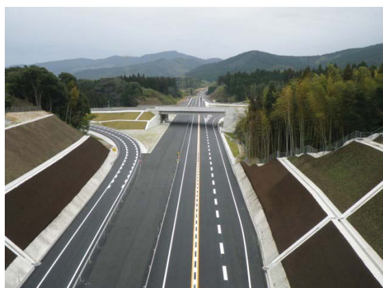
薩摩川内都インターチェンジ（都町）
