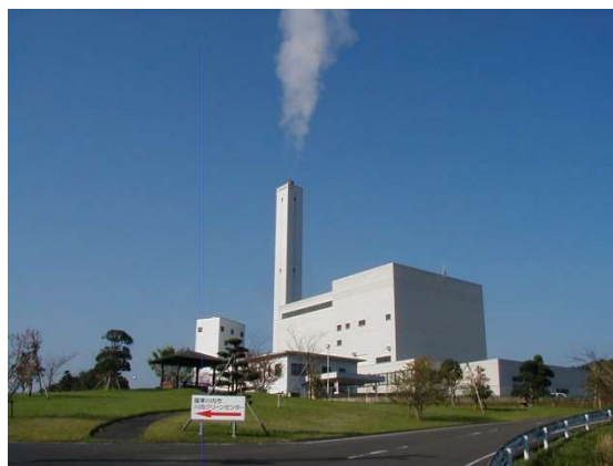
川内クリーンセンター（小倉町）
