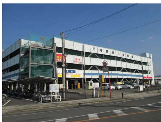
川内駅西口駐車場（鳥追町）
