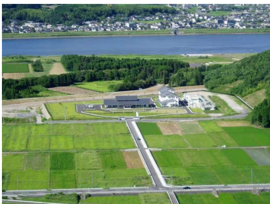
宮里浄化センター（宮里町）
