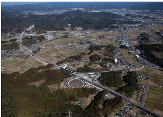
薩摩川内都インターチェンジ（都町）
