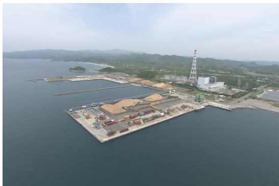
重要港湾川内港（港町）
