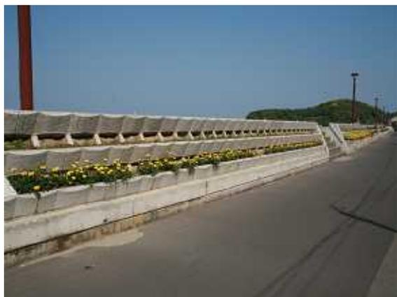
コンクリート擁壁に植栽可能な構造部分を設けることで，無機質なイメージを少なくしている。
