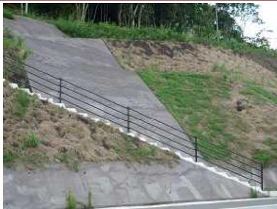
全面的なコンクリート仕上げとせず，部分的に植栽可能な擁壁とすることで，自然環境に調和するように工夫している。
