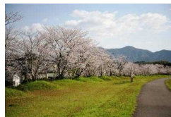
田海川堤防(川内)
