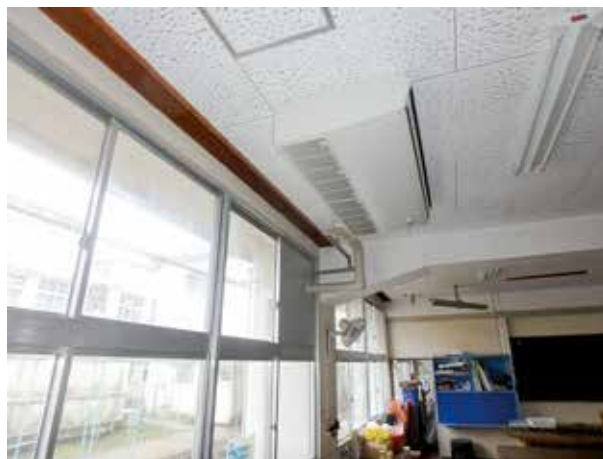
教室への空調設置
