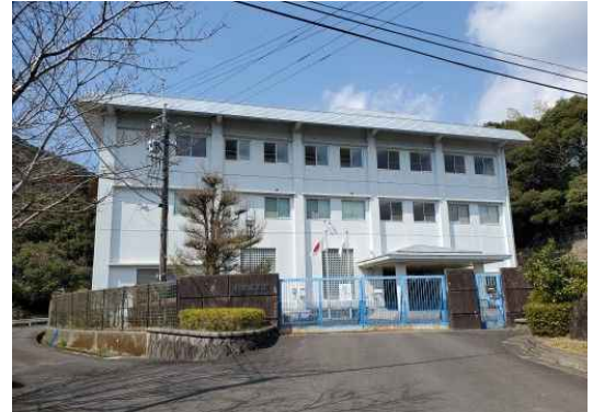
川内地域丸山浄水場管理棟
