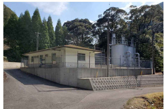
東郷地域中津俣浄水場
