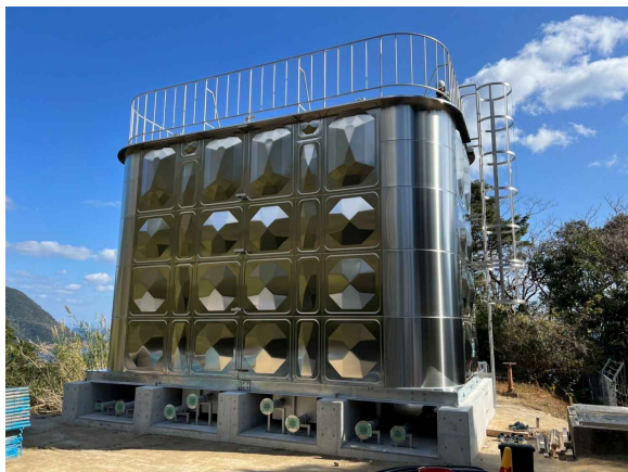
長浜配水池更新工事
