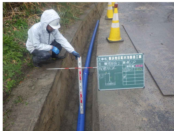
長浜管路更新工事
