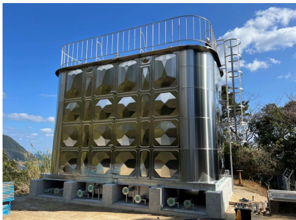
長浜配水池更新工事
