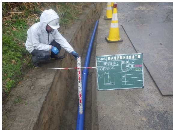
長浜管路更新工事
