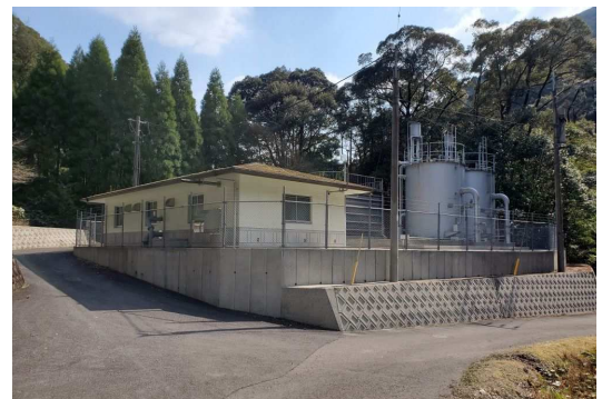
東郷地域中津俣浄水場
