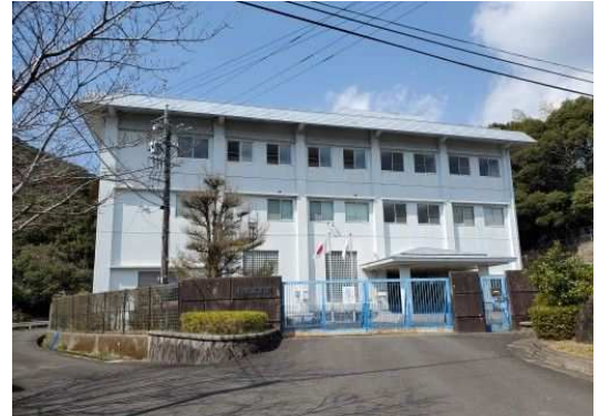
川内地域丸山浄水場管理棟
