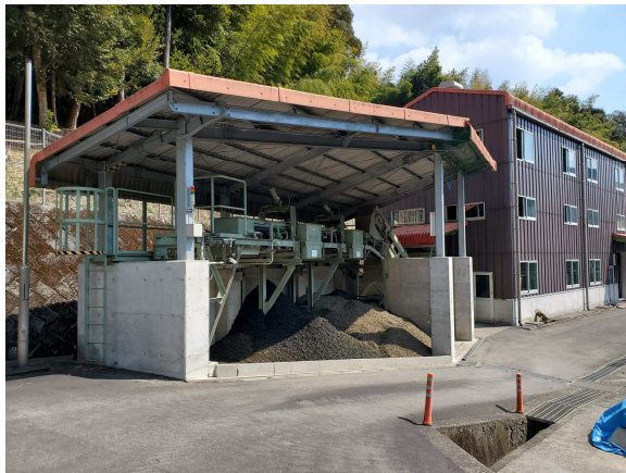
丸山浄水場 機械脱水(ケーキヤード)の様子
