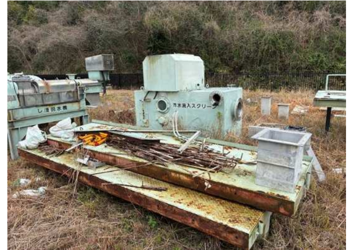
写真: 撤去状態(撤去材)
