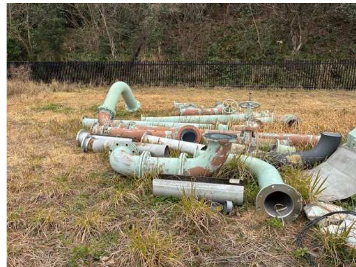
写真: 撤去状態(撤去材)
