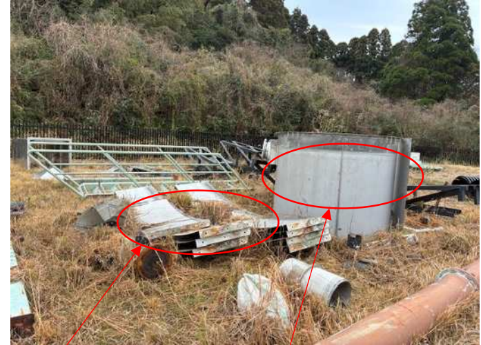
写真:撤去状態(撤去材)
