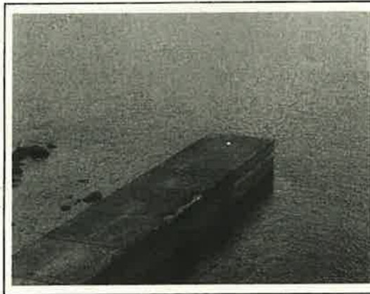
甌大明神橋下 灯台倒壊
