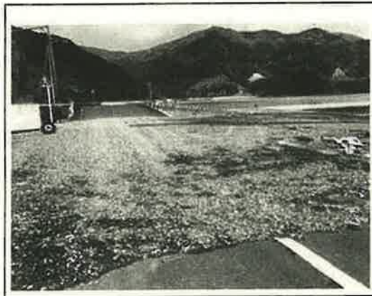
上甌町平良 道路側溝状況
