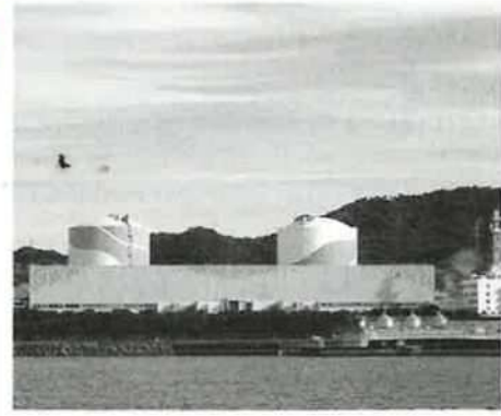
川内原子力発電所
