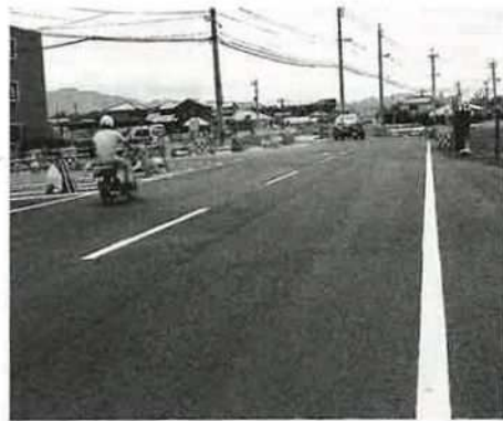
県道山崎川内線
