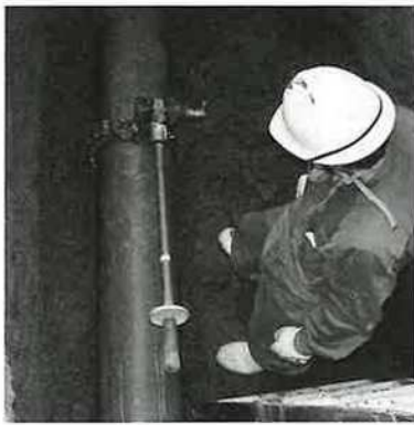
石綿管の切替工事
