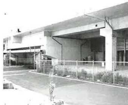
市道横馬場・田崎線改良予定地
