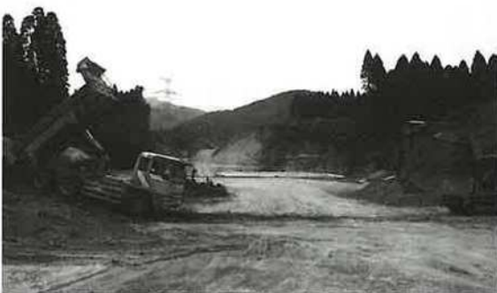
南九州西回り自動車道 薩摩川内都インター建設現場
