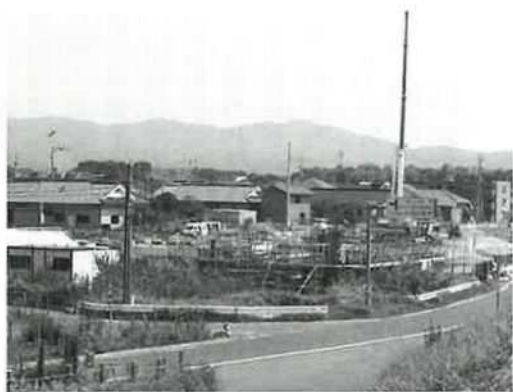
香田樋門改築工事
