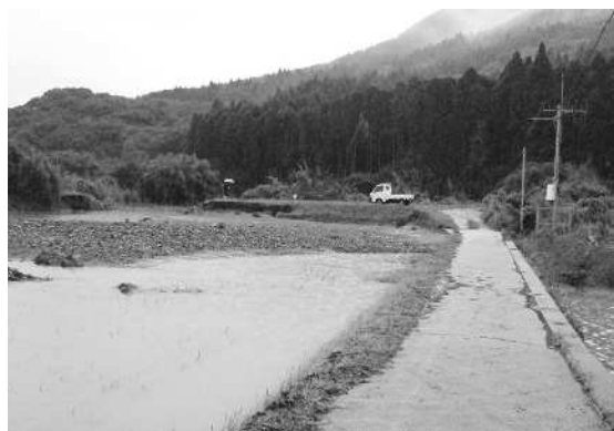
高城川崩壊現場
