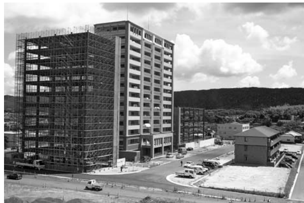
川内駅東口の高層建築物
