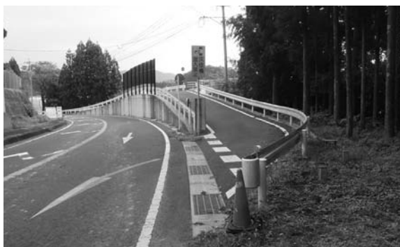
久住橋への進入ができない国道267号(東郷町)
