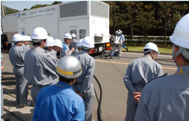
新たに導入された移動式大容量発電機の訓練 (4月12日)
