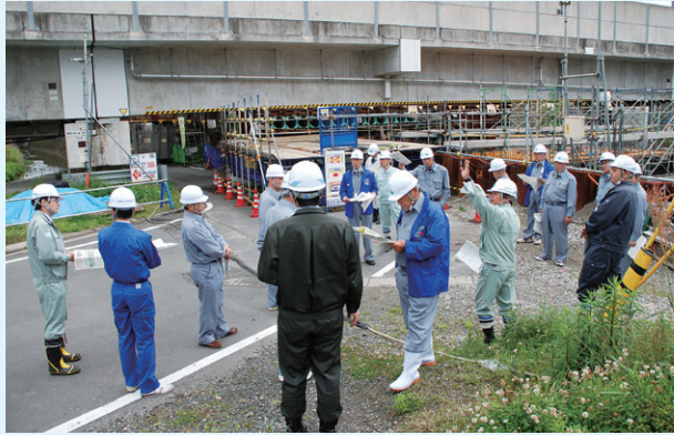
横馬場・田崎線整備事業 アンダー部分工事
