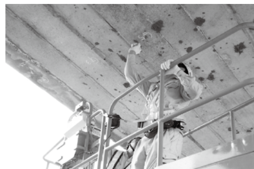
橋りょうの点検作業
