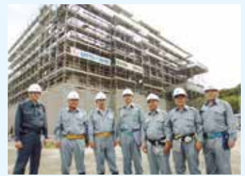
消防庁舎の工事状況
