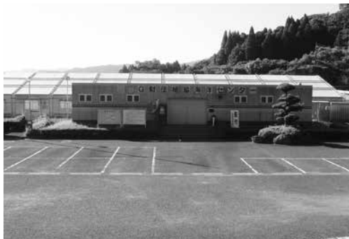
樋脇B&G海洋センター
