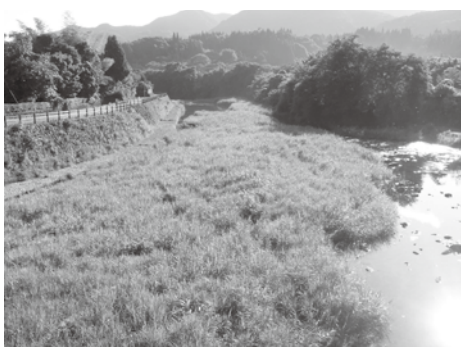
葦が繁茂している寄洲(樋脇川入来町船瀬橋下流)
