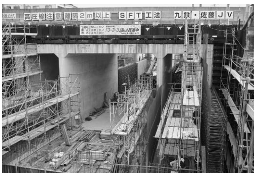
横馬場田崎線のアンダー部分工事
